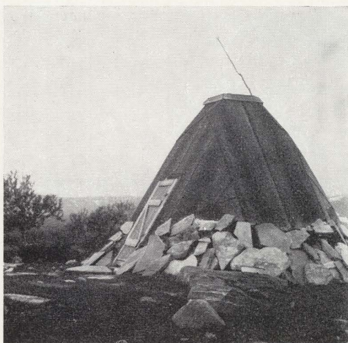
Fig. 21. Ordningsmannen Lars Johanssons moderniserade pappklädda brädkåta med bågstångskåtans golvplan. Bredd 440 cm, djup 380 cm, höjd till grytåsen 200 cm, till räppen 285 cm. Foto förf. 1943.
