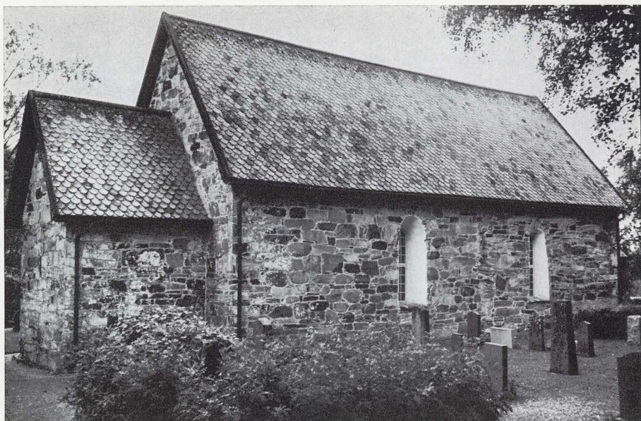
Äre gamla kyrka. Kyrkans norra vägg, där skarven mellan den gamla och den nyare delen syns mellan de två fönstren. Den hitre delen är äldst.
